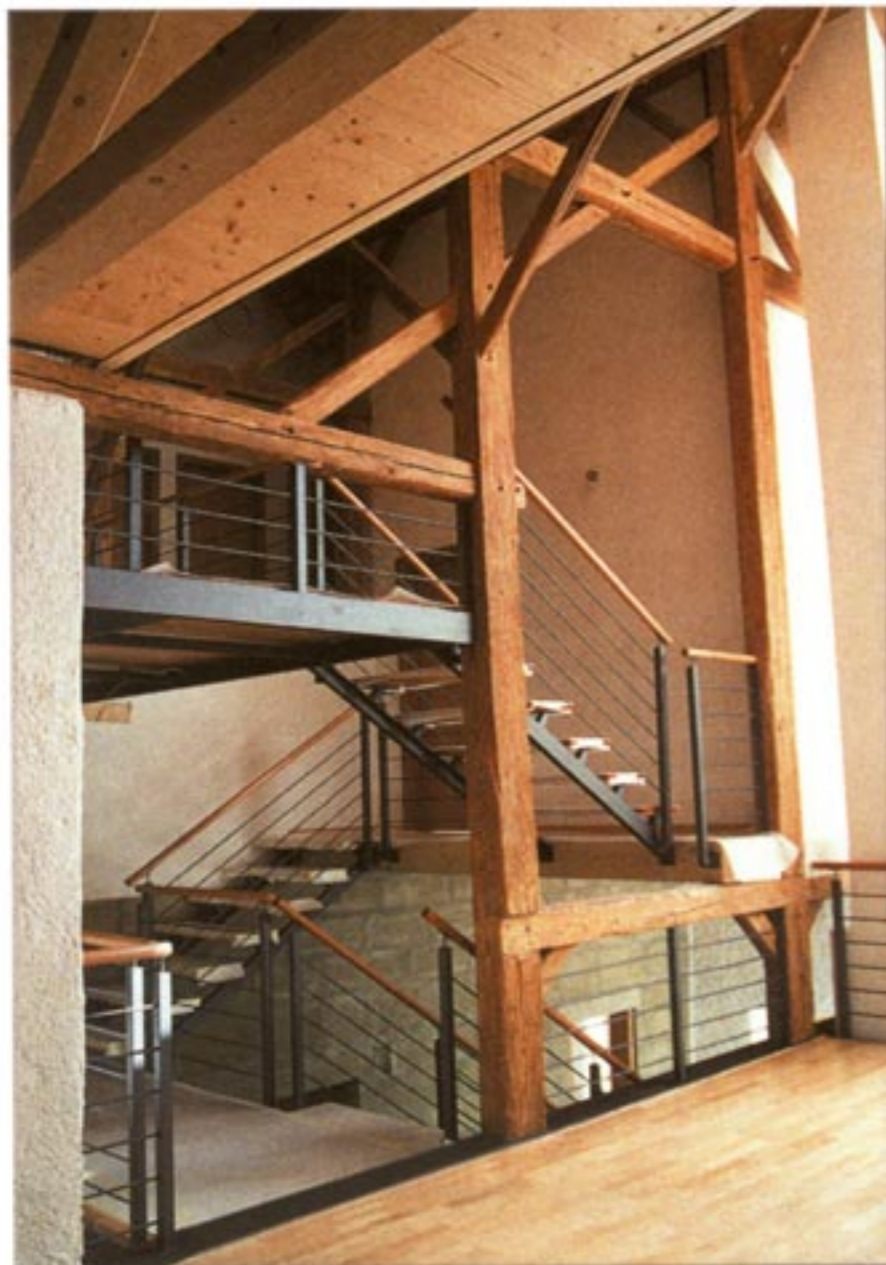
Au centre l'escalier en métal et marches en hêtre verni
