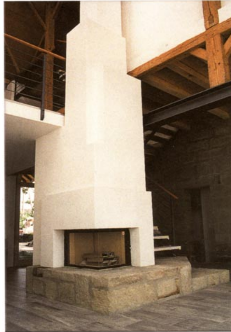
Le socle de la cheminée et de l'escalier en molasse récupérée sur place
